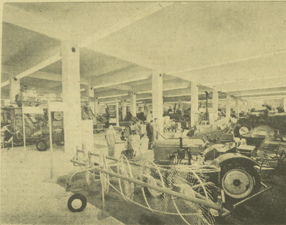
Scorcio d'uno degli imponenti saloni del nuovo Palazzo dell'Agricoltura, costruzione che è venuta ad inserirsi di buon diritto fra i «giganti» dell'edilizia fieristica e che ha il pregio di raggruppare i vari aspetti d'uno fra i più interessanti settori merceologici della Campionaria
